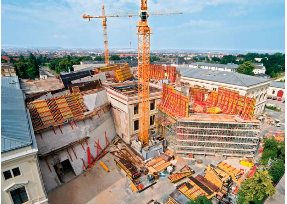
Das alte Treppenhaus inmitten der zum Teil noch geschalteten schrägen Wände des Keils Foto: Peri
