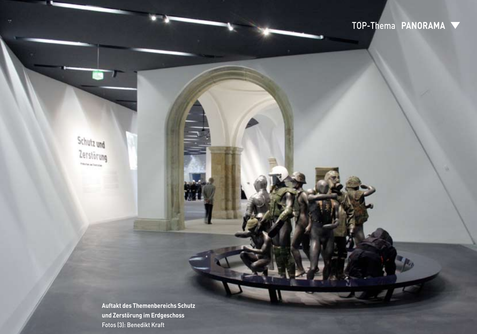
Eine 10 cm breite Fuge trennt den Altbau innen von den schrägen Neubauwänden (links) und außen von der Stahlkonstruktion des vor die Fassade gesetzten Keils (rechts)
