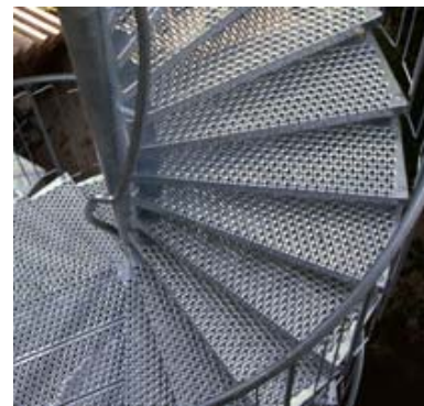
Spindeltreppenstufen und Podeste
